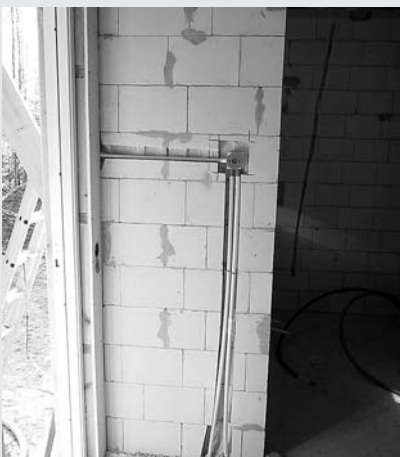
Kuva H1-K6. Putkituksen ja rasiointin kiinnitys juottamalla harkkoseinään.
