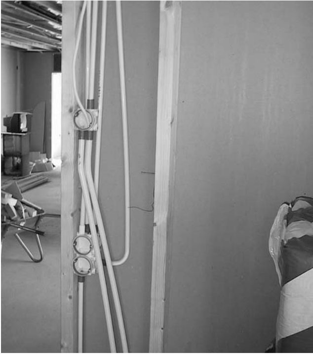
Kuva H1-K4. Putkitusta ovipielessä, lämpöeristämätön seinä.
