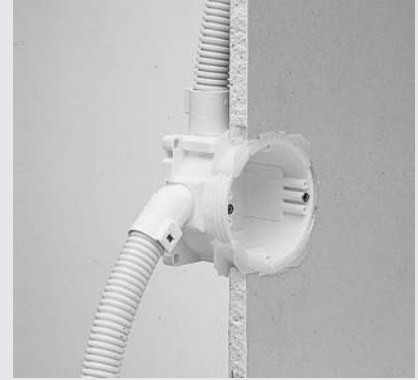
Kuva H1-K11. Kojerasian kiinnitys levykiinnikkeillä. Levyyn porataan 74 mm:n reikä, kiinnikkeet asetetaan reikään ja rasia työnnetään takaapäin paikoilleen.
