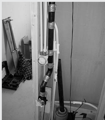
Kuva H1-K7. Syvyysuunnassa säädettävä (-2...+16 mm) kojerasia sivunaulauksella kiinnitettynä.
