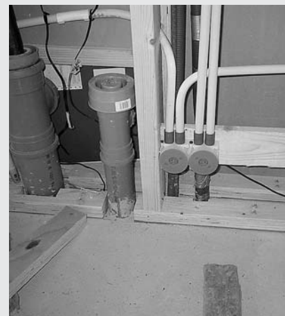
Kuva H1-K8. Sama rasia kuin kuvassa H1-K7 yhdistelmän ja kiinnitetynä asennusalustaan.
