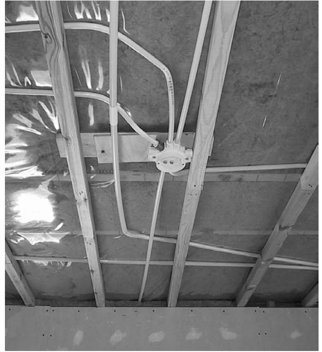
Kuva H1-K5. Kattoputkitusta ja kattorasian n. 50 mm:n joustava kiinnitys.
